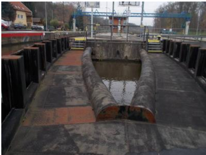
HO středové svodidlo MPK i VPK z LB MPK
